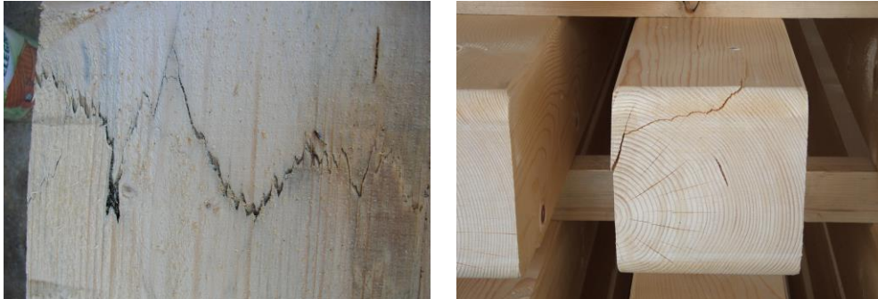
Fig. 11 – Lesioni sulla faccia (sx) o in testa all’elemento (dx)
